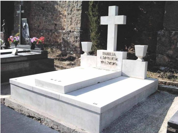
La limpieza se ha realizado por medio de un lijado de los planos y limpieza con la pistola de arenado, en las rendijas, rincones esquinas juntas y zona de letras de difícil acceso.
