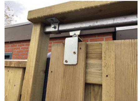
5. Bundstyr, skruet fast på stolpen eller pladen.
