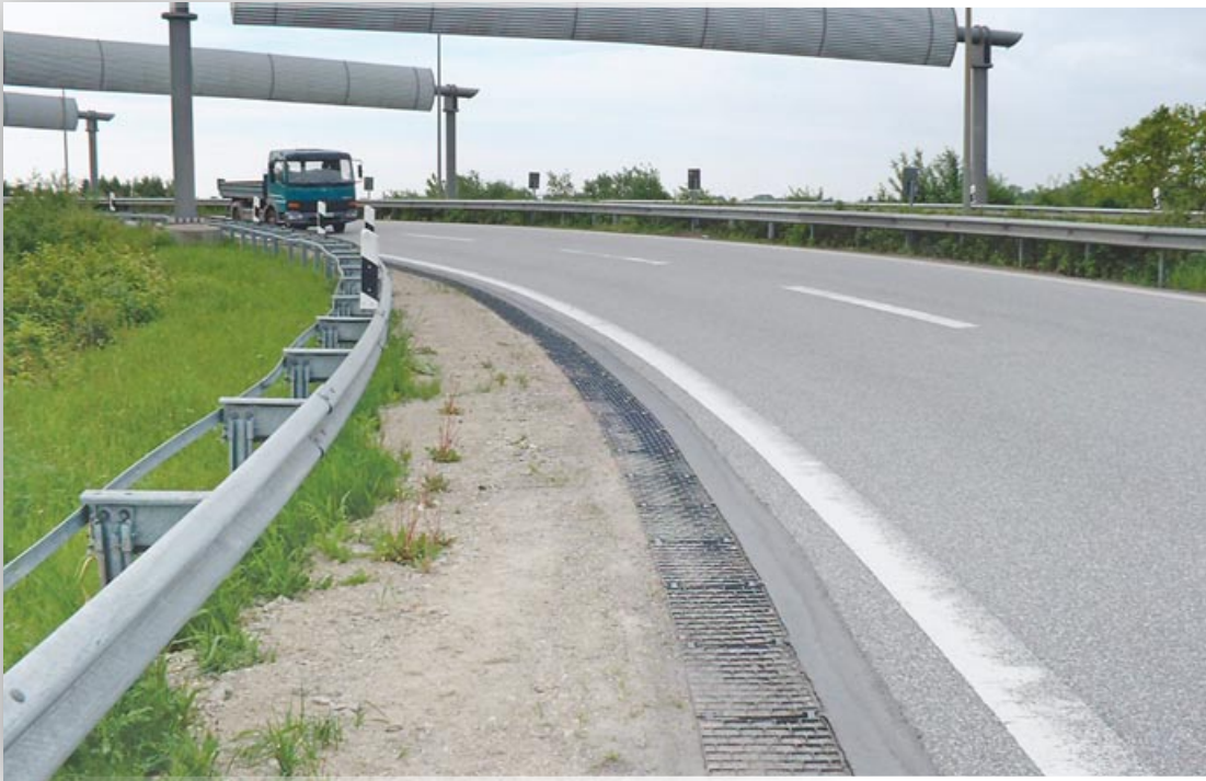
RoadEdgePave beskytter asfaltkant og beskytter mod frostskafer
