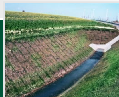
MultiFlixx tilbyder et utal af muligheder som erosionsbeskyttelse for dæmninger.
