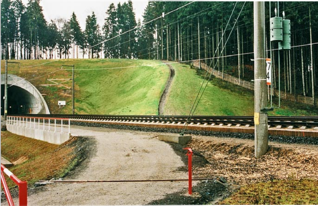
Grøfter forstærket med ProGrassFlex giver regnvand frit løb
