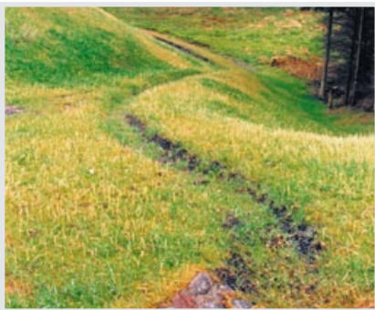
En grøft forstærket med ProGrassFlex.
