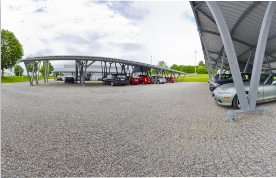
GravelGrid er blevet brugt under disse sol carporte for at skabe en billig, forstærket parkeringsplads til medarbejderne.
