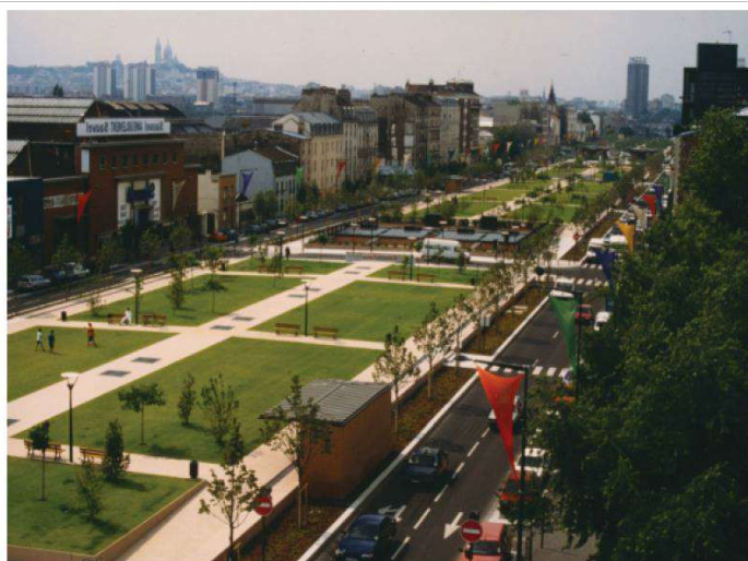
Figure 30 : Référence – couverture de l'autoroute A1, Paris
