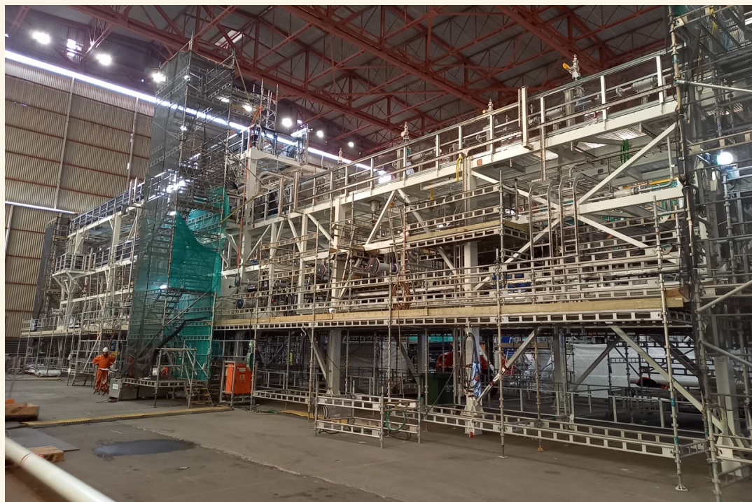
Rørgate nærmer seg ferdig hos Aker
