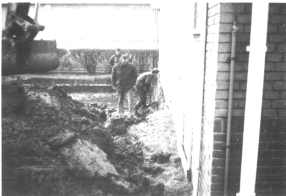
Graven van de bouwput. Lies Joppe en Fa. J. de Blok.
