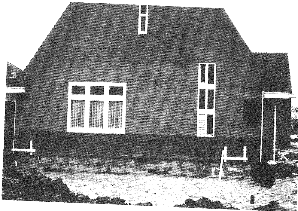
Laatste blik op de "bestaande oostgevel" februari 1984
