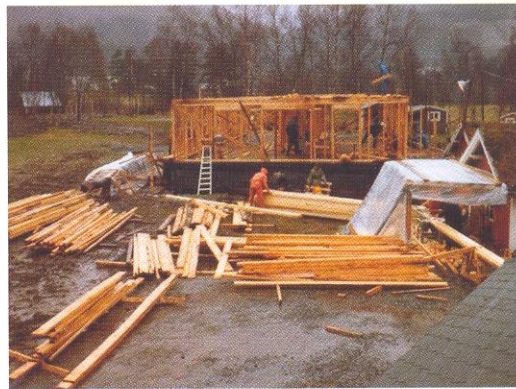
Internatbygget ble reist, i et forferdelig uvær, på 2 døgn, 21. og 22. oktober 1983.
