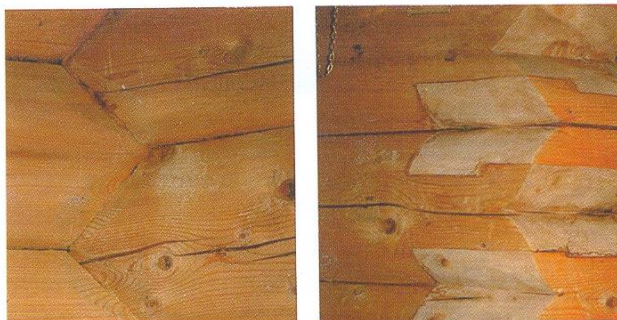
Håndtverksarbeid av ypperste klasse på Visthus. Vi ser en «fransk lås», og den renges som den faglig mest krevende og beste bjelkeskjøt.
