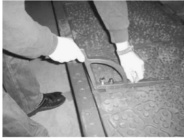
Sett FU nøkkelen i nøkkelhullet og sikre den med strammeskruen
