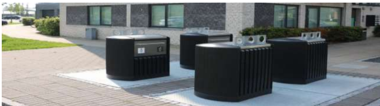
Figur 2: Eksempel på affaldsstationer med VF600, størrelsen af en brønd er 2x2 m.
