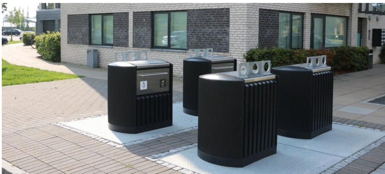
Figur 2: Eksempel på affaldsstationer med VF600, størrelsen af en brønd er 2x2 m.
