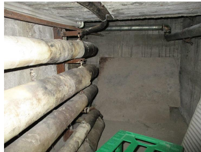
Indgang til teknikkanal.
