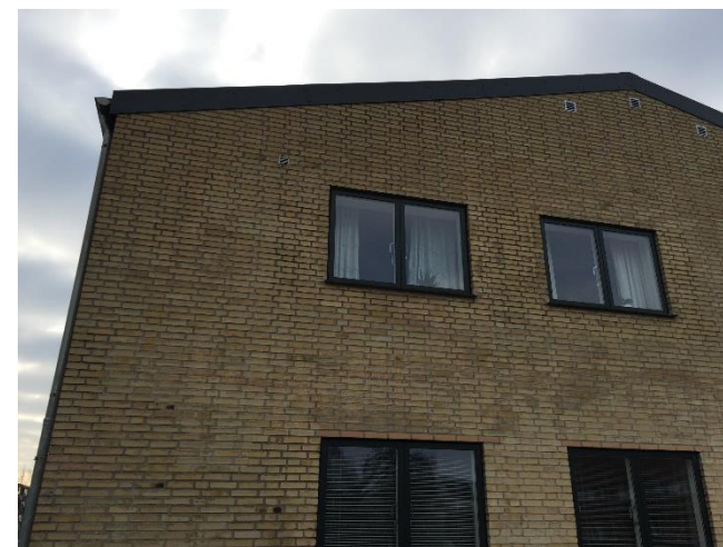
Vinduer er af samme type/opbygning på alle bygningerne.
