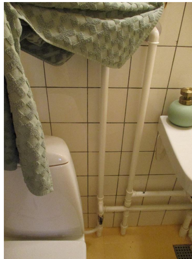
Rørinstallation i badeværelse.
