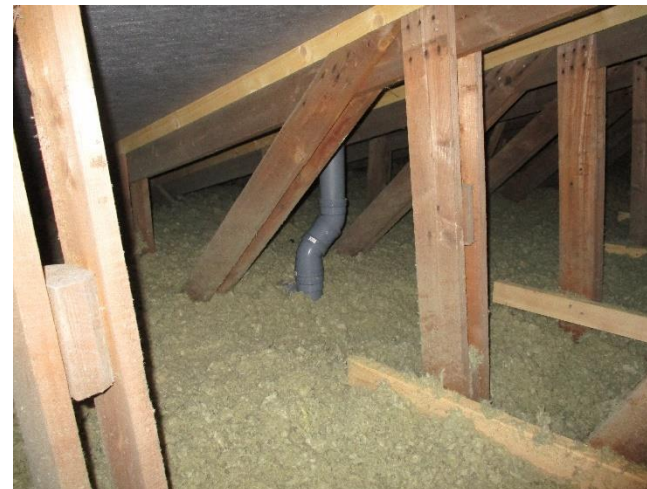
Faldstammeudluftning i tagrum udført i PVC.
