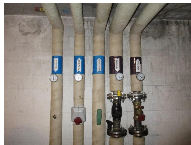
Varme- og brugsvandforsyning til Blok 3B.
