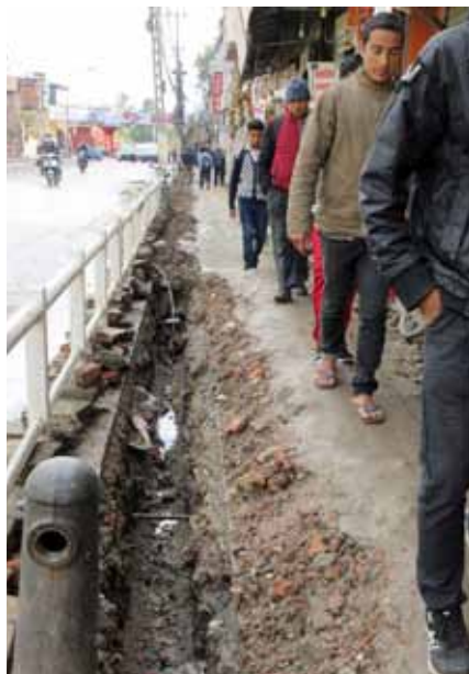
Opgravning ved Kantipath
