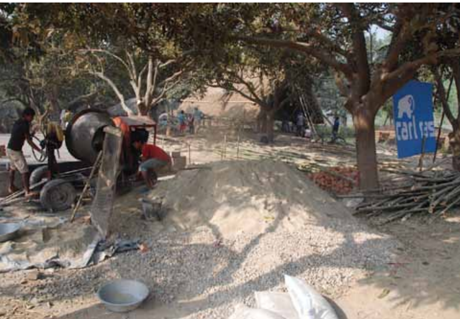
Byggepladsen til byggemarkedet. T.v. bag betonblanderen står fundamentet til et kombineret kontor og magasin til maskiner og værktøj. T.h. tækkes taget af en lagerbygning til cement og mursten. Der er planlagt to lagerbygninger mere, én til imprægneret bambus og én til miscanthus. Carl Ras har leveret værktøjet til workshoppen. Mangotræerne er i fuld blomst.
