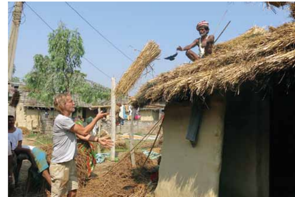
Her er rollerne byttet om. Nepaleserne demonstrerer, hvordan de traditionelt tækker tage, nemlig med rishalm i et forholdsvis tyndt lag på flad rejsning. Bjarne langer neg op, bundet med halmsimer.
