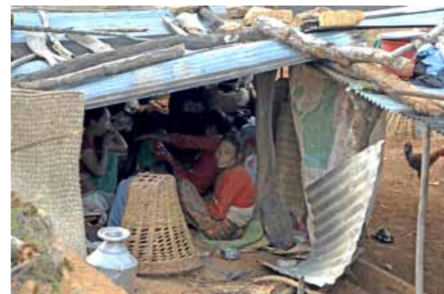
Utæt tagdække: Midlertidigt husly bygget af blikplader, stråmætter og andre materialer bjerget fra familiens ødelagte hus. Sindhupalchowk.
