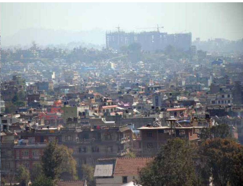
Inden for få år vil et jordskælv af stor styrke med stor sandsynlighed ramme millionbyen Kathmandu. Alligevel bygges selv nye bygninger ikke til at kunne modstå jordskælv.
