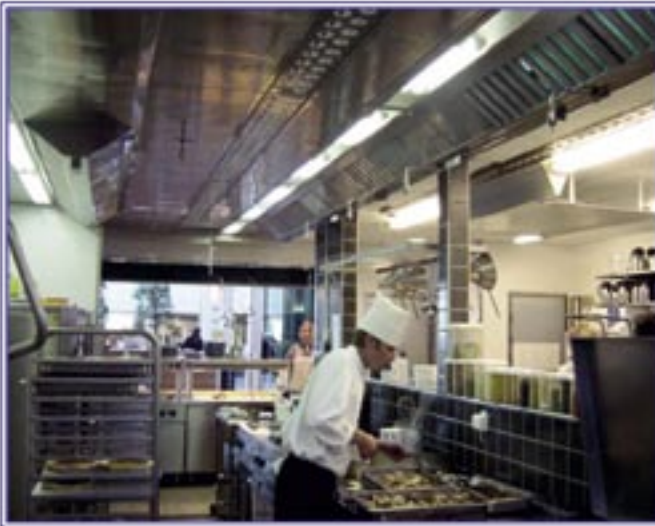
Hette met fettfilter og styreluft for storkjøkken
