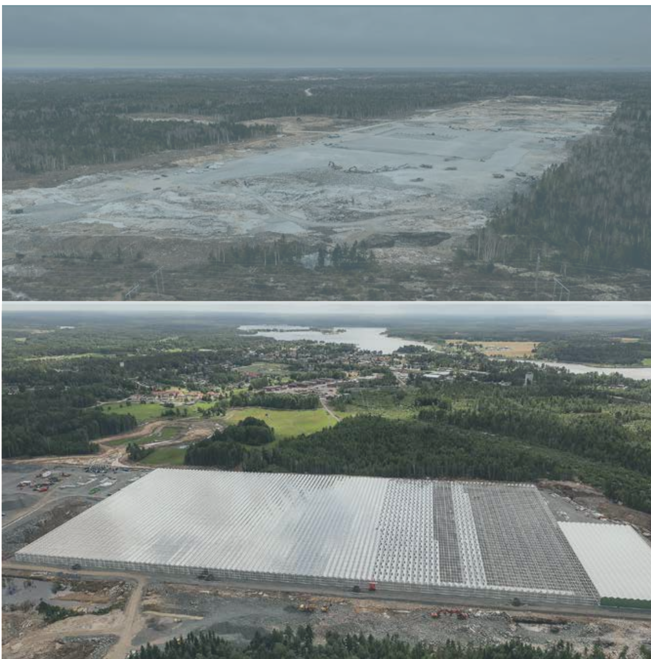
Navigos Navbolag Vinga arrangerade finansiering för WA3RMs växthusprojekt Regenergy Frövi beläget i Lindesberg kommun. Övre bilden från utvecklingsfasen, där även innehavet Nordisk Bergteknik deltog i det 217 000 kvadratmeter stora växthusets genomförande.
