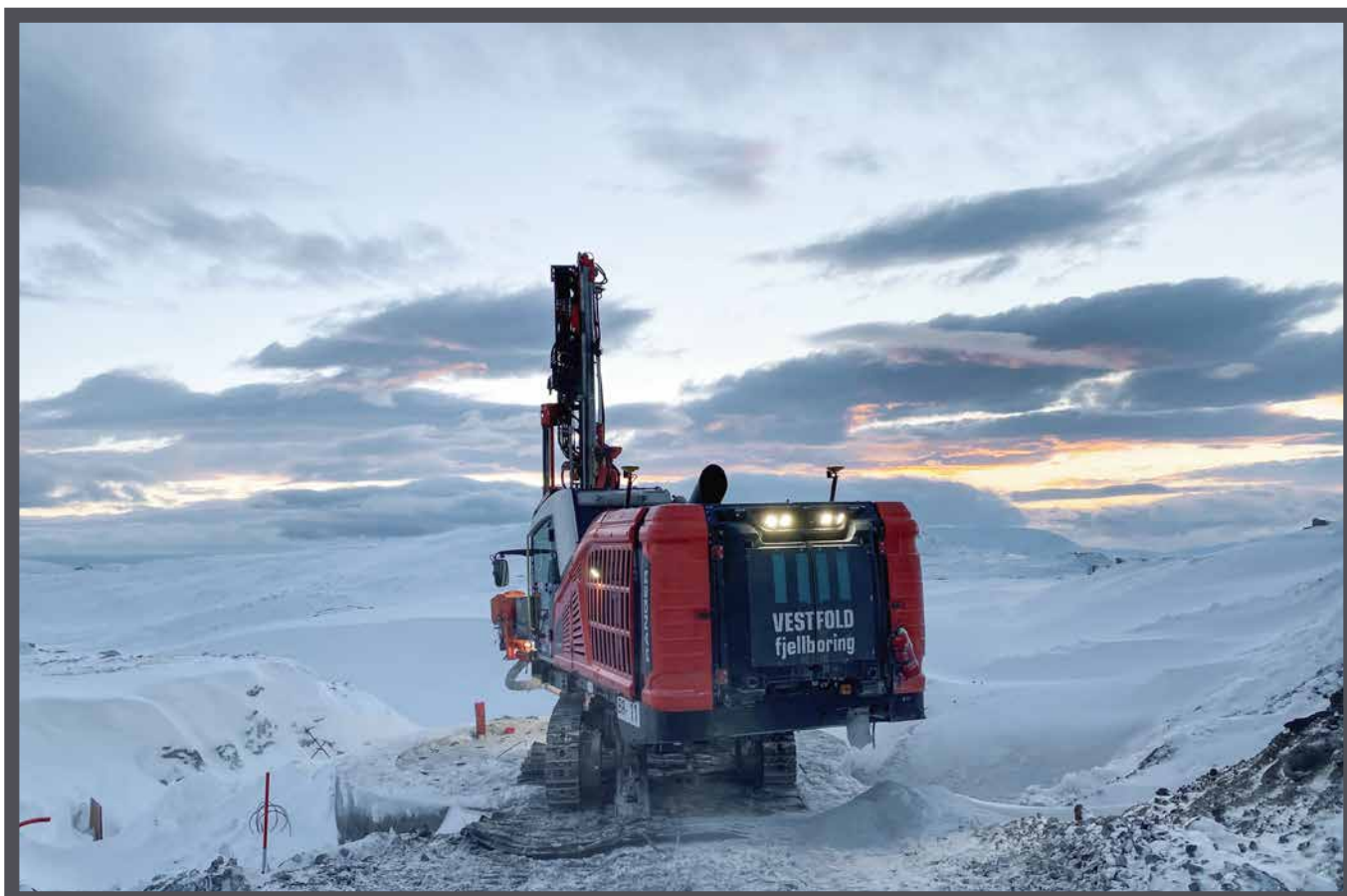
Vestfold Fjellboring under arbetet med bergsborring på Øyfjellets vindkraftspark i Norge.
