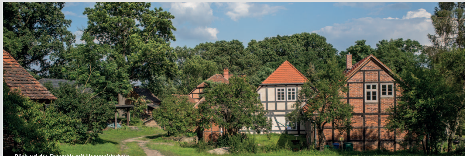
Blick auf das Ensemble mit Hegemeisterhaus
