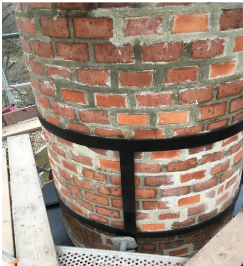
Vertikala förstärkningsjärn. En säkring för framtiden. Svetsades till järnkransen.
