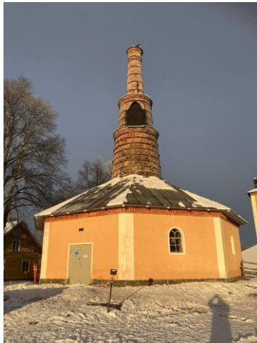
Här syns de nya förstärkningsjärnen som är förankrade i den tjocka avtäckningsplåten på översta utkrängningen. Järnen är av samma dimensioner som järnringarna och säkrar mot tippning.
