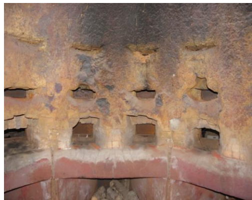
Lufthålen nedtill i rostugnen.
