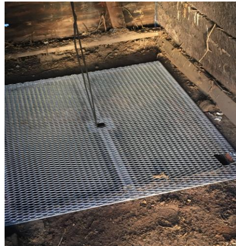
Galler som skydd för nedfallande stenar. Säkrare än fågelbo.
