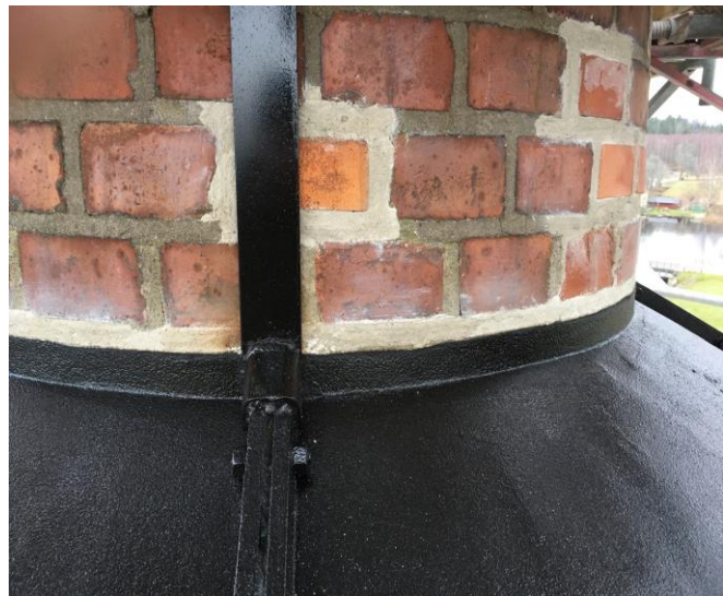
Vertikala förstärkningsjärn. En säkring för framtiden. Svetsades till järnkransen.
