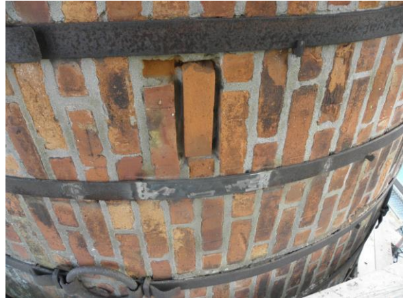
Utbytt sten och lagad järnring på nedre delen av skorstenen
