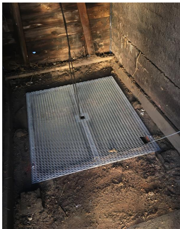
Luckplanet med ett rektangulärt hål som täckts av en gallerdurk
