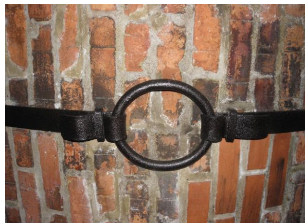
Vertikala förstärkningsjärn. En säkring för framtiden. Svetsades till järnkransen.
