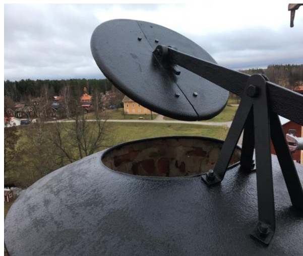
Topplocket säkrat med järn på undersidan.
