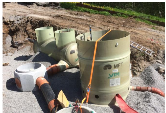
MFT GRP-kum med MFT tverroverløp under montering
