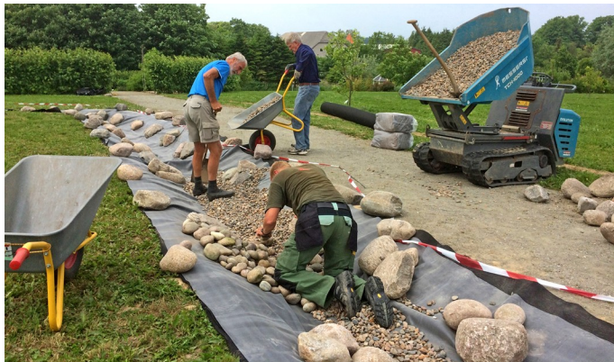
Fritz Johansen fra Junckerhaven fordeleer sten i det kommende vandløb assisteret af Bent Bundgaard og Bjarne Møller Pedersen (med trillebøren).
