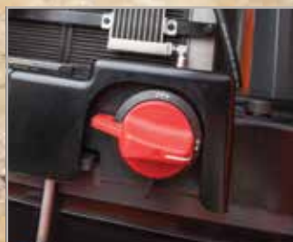
Interruptor de corte de la batería
