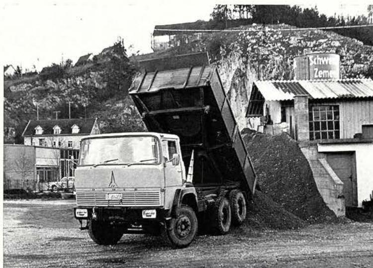
12 800 kg Schotter werden nach vorangegangenen Test mit voller Nutzlast abgekippt, um das Fahrzeug nun im Leerzustand eingehend zu prüfen.
