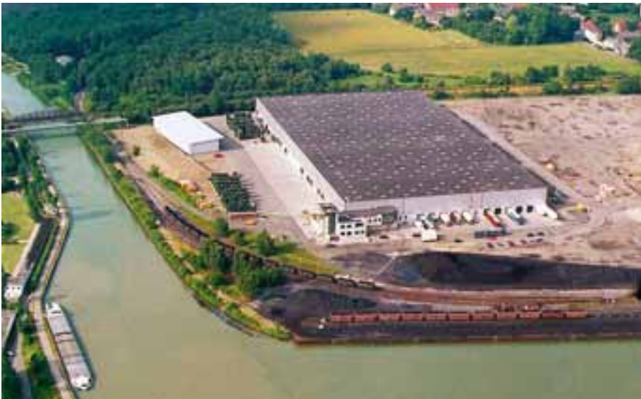
Das Fiege Mega Center Dortmund auf dem ehemaligen Zechengelände Fürst Hardenberg
