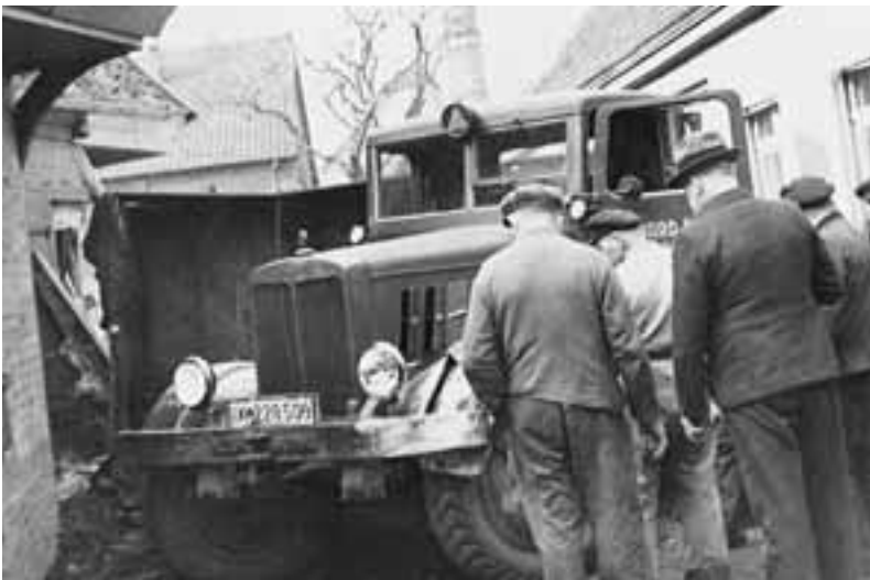
Begutachtung vor dem Ausschachten
