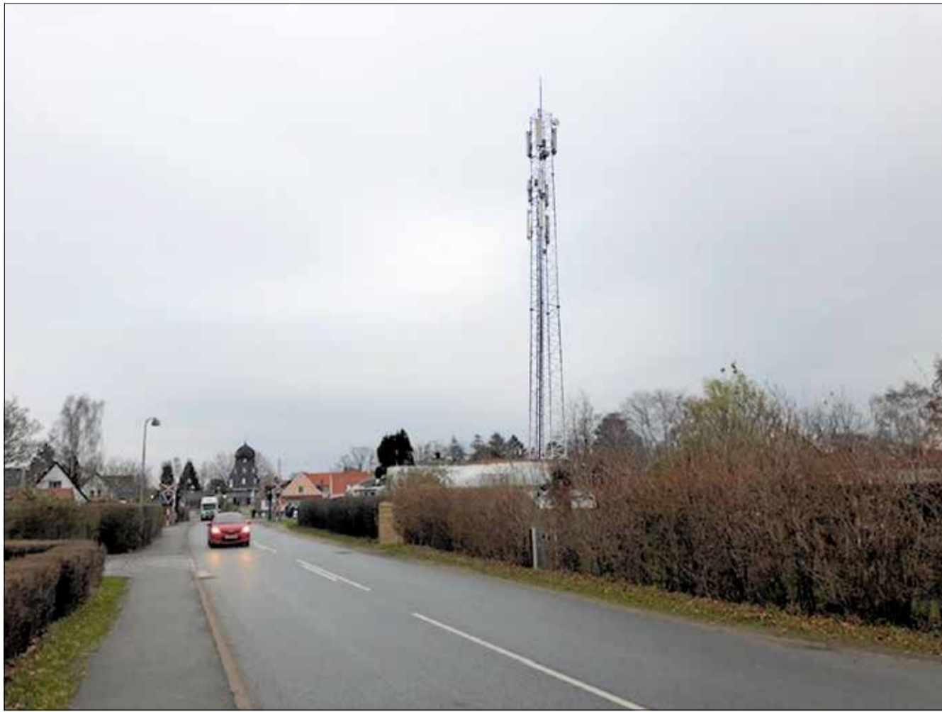
Billedmontage af TDC-antennemasten m. tilhørende tekniske anlæg ved Dronningmølle stationsområde set fra Villingerødvej mod Dronningmølle Strandvej. Billedkilde: Dronningmølle Borgerforening - Per Laursen.
