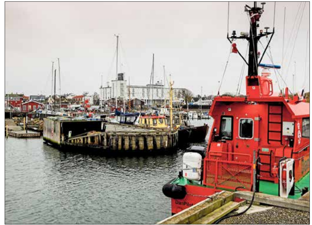
Hornbæk Havn er ved at blive repareret og renoveret.
