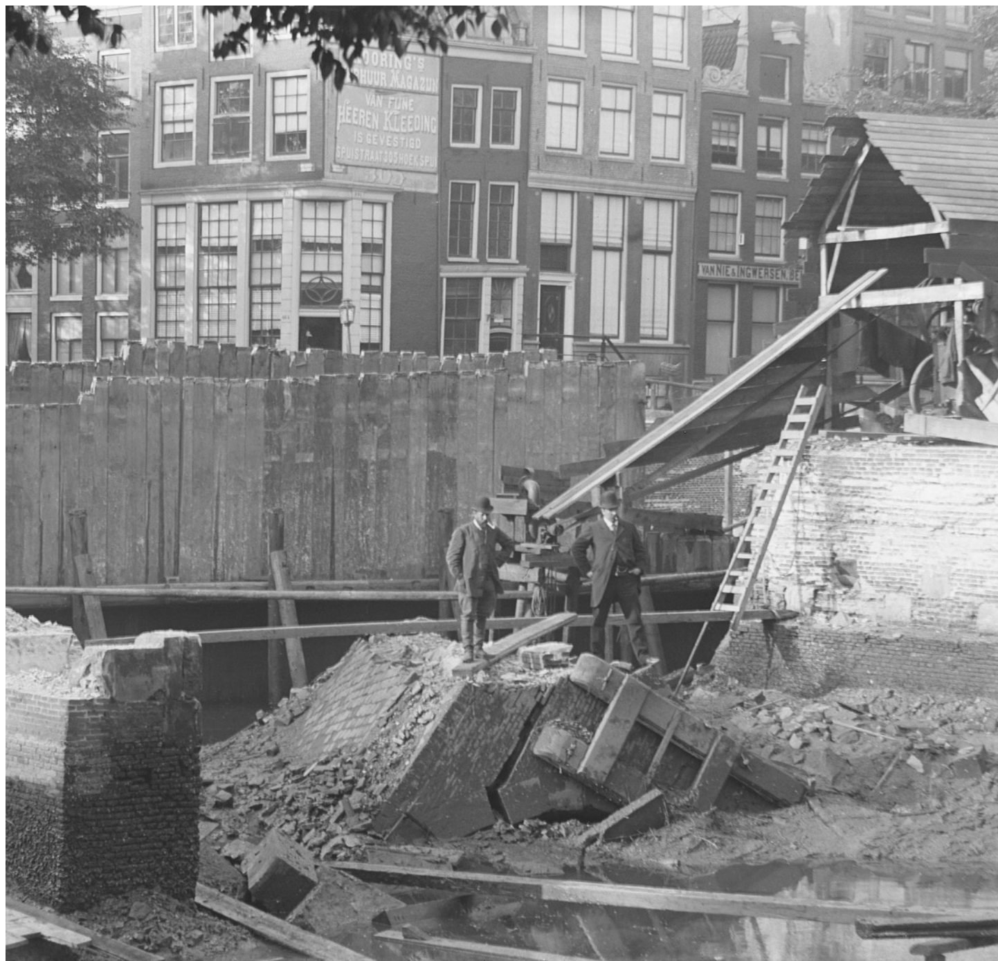
Foto: Ingestorte brug nr.46 Keizersgracht/Leidsegracht Bouwput voor opbouw Collectie Jacob Olie 18 mei 1895
