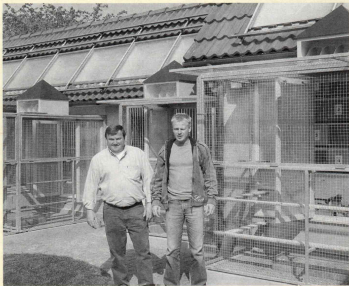
Leif og Martin foran slaget. Bemærk de nye store volierer, som bliver brugt til at styre udluftningen og giver mulighed for at bade duerne uden risiko for angreb fra rovfugle. De er udstyret med betondek med afløb, således at de er nemme at rengøre.
