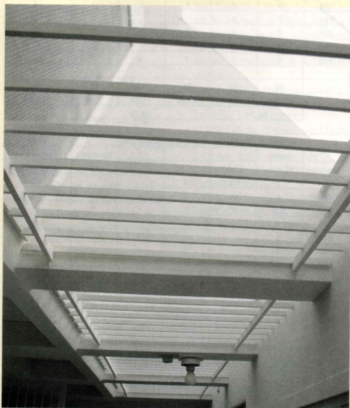
Nye ventilationsriste i loftet
