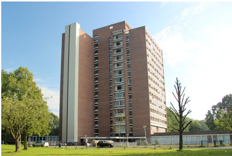
Nieuweroord in haar huidige vorm
