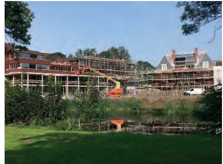
Nieuweroord in aanbouw: 'een groene enclave, te midden van gewilde woonmilieus', 2020
