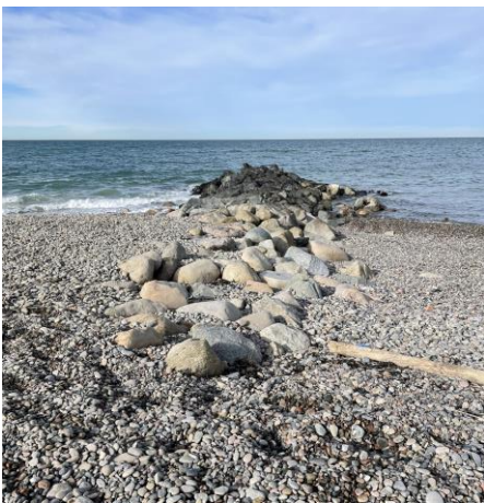
Figur 2.9: Billeder fra området ved C. Der ses spredning af både filter og dæksten samt lunke i skaftet.
