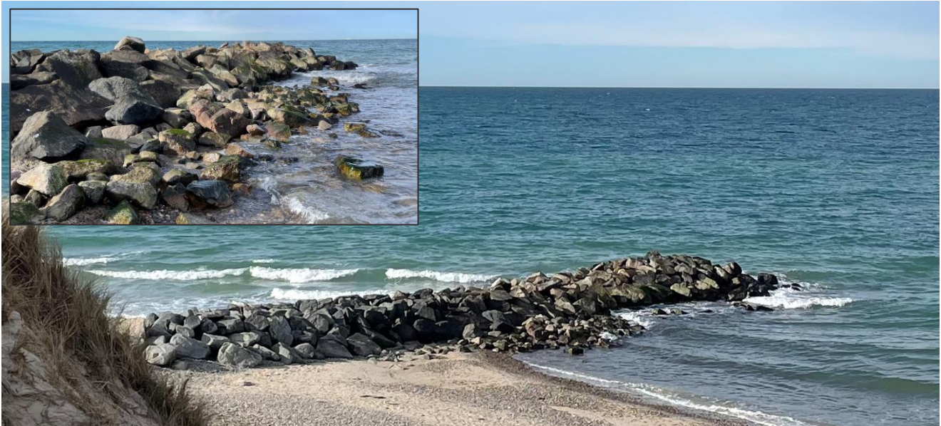
Figur 2.9: Billeder fra området ved C. Der ses spredning af både filter og dæksten samt lunke i skaftet.
