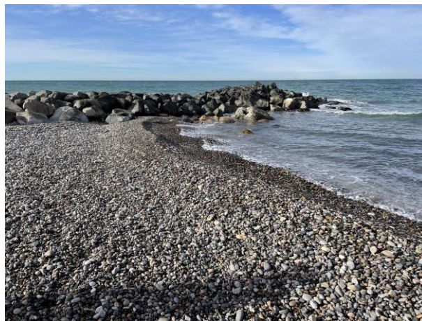
Figur 2.9: Billeder fra området ved C. Der ses spredning af både filter og dæksten samt lunke i skaftet.
