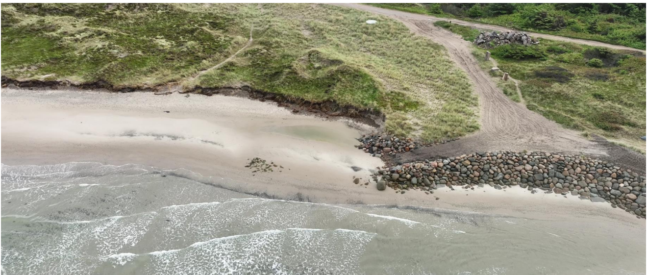
Figur 2.14: Erosion på nordøst siden af Højen Fyrvej. Dronefotos leveret August 2023.
