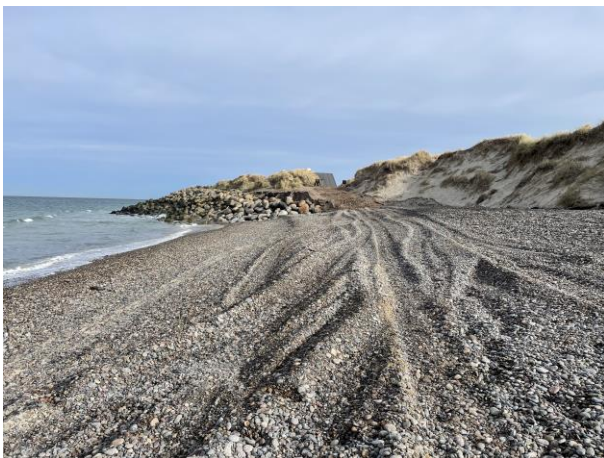
Figur 2.12: Billeder fra området ved D, syd for Højen Fyrvej 49. Der ses stor mængde ral højt i strandprofilen og spredte sten ved hølfer.
