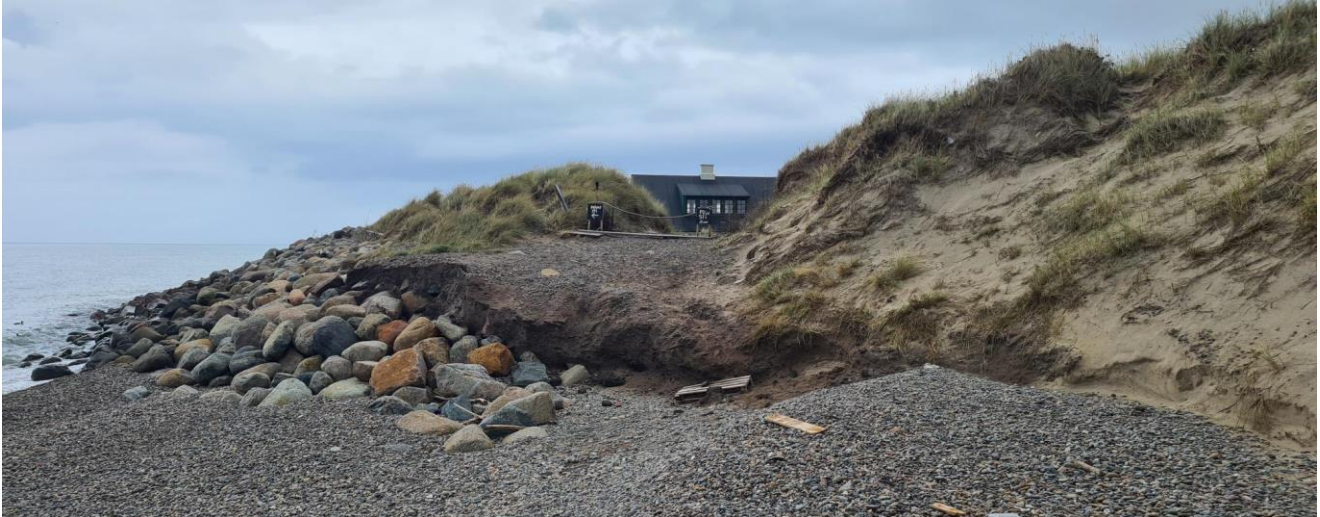
Figur 2.13: Skrænten på sydsiden af Højen Fyrvej hvor der er sket erosion ifm. stormvejr i midten af august 2023 (Fra kystlaget 2023).
