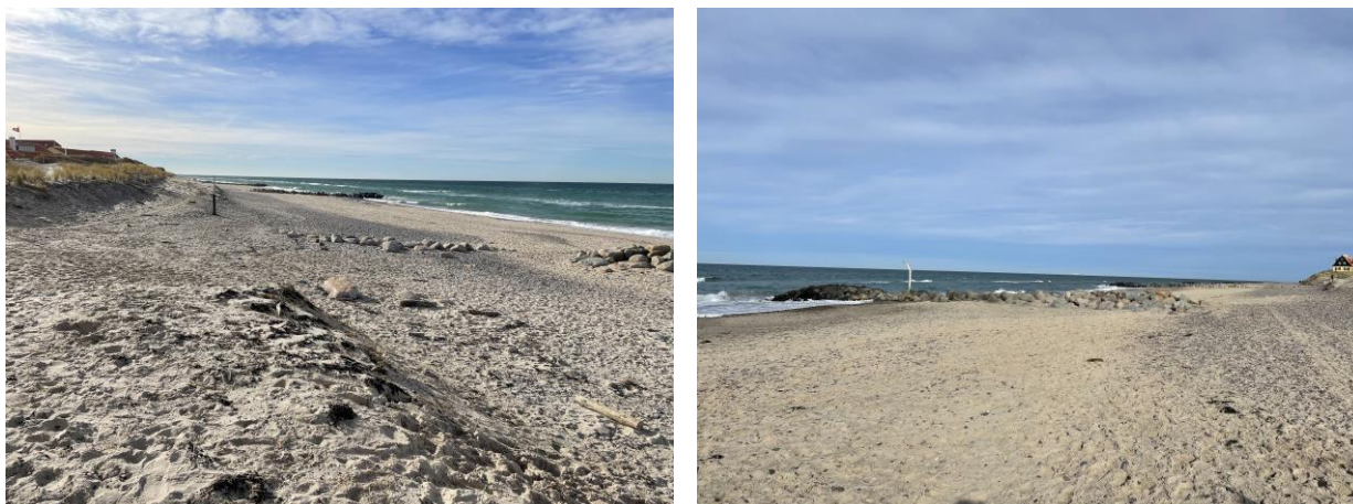
Figur 2.8: Billeder fra området ved B. Der er her en lidt større grad af ral højt i strandprofilet, men stadig udpræget sandstrand. For område C ses i højere grad lunger i høfde skafterne, nedfaldne sten og i højere grad ral på stranden i stedet for sand. Klitfoden ser ud til at være påvirket af bølger men ikke med nylige skred. Der var ved høfdehoveder tegn på fordybelse ved hovederne i form af større bølger tæt på stranden.
