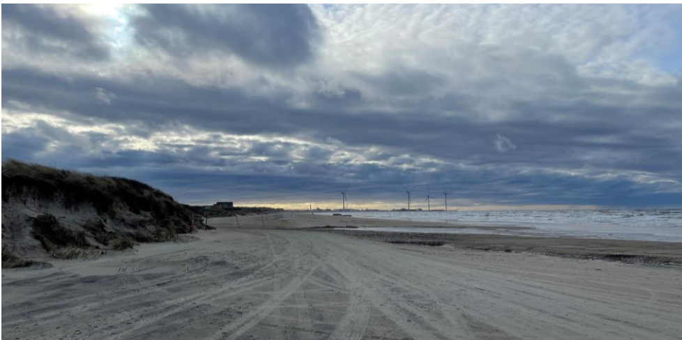
Figur 2.10 Strand og klitter ved nedkørslen til Kjøl Strand set mod vest, 04.04.2022. Der ses erosion i klitfronten.
