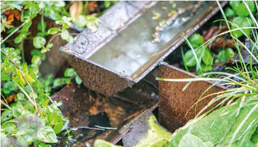
Metalskinner leder regnvandet væk fra vejen og fortovet og ned i klimabedene.
