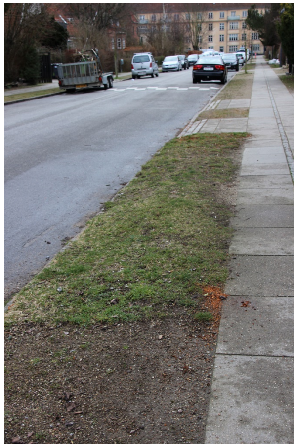
Fortov før afgravning
