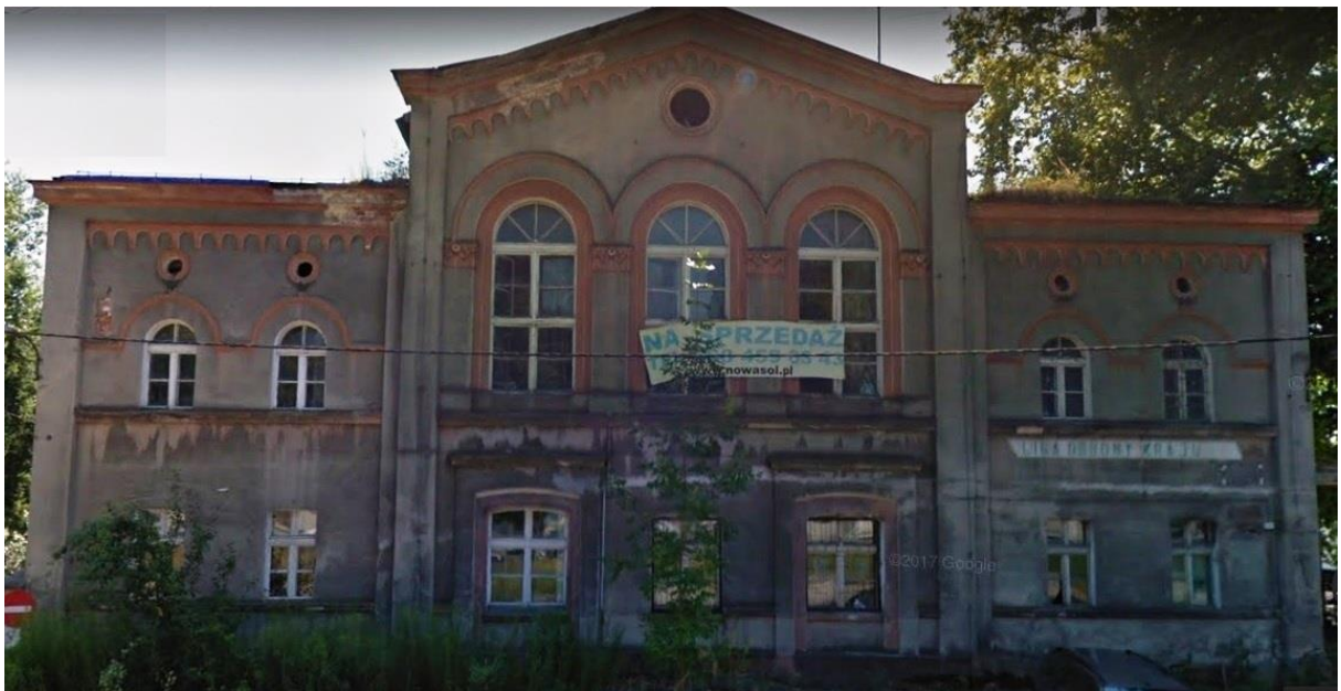
De voormalige dancing "Das Schützenhaus" voor de renovatie van het pand.
