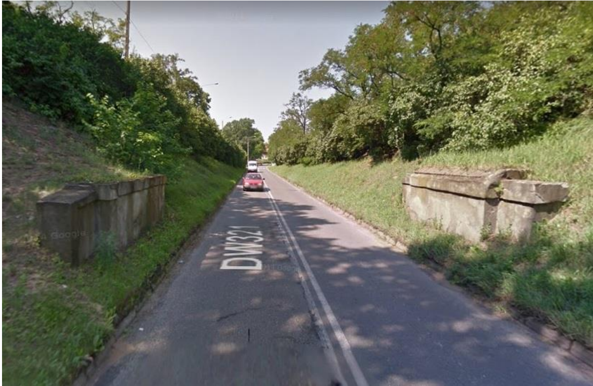
Mogelijke restanten van de hefbrug. Een hotel is er niet meer.
