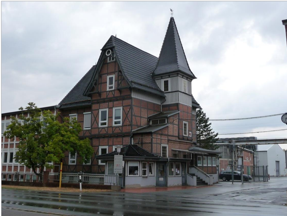
De inrit aan de Bahnhofstrasse met portiersloge en directeurswoning in 2018 (foto E. van der Most)
