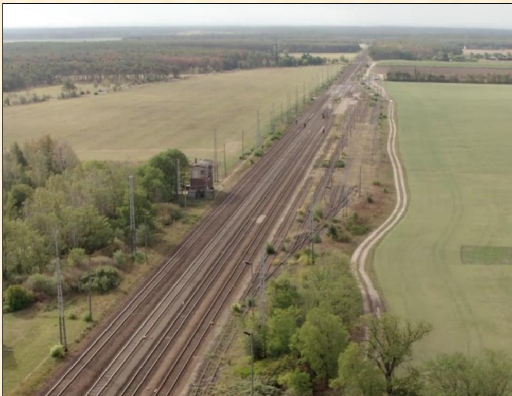
Het overgroeide emplacement van Neuburxdorf (drone opname NIMH 2020)
