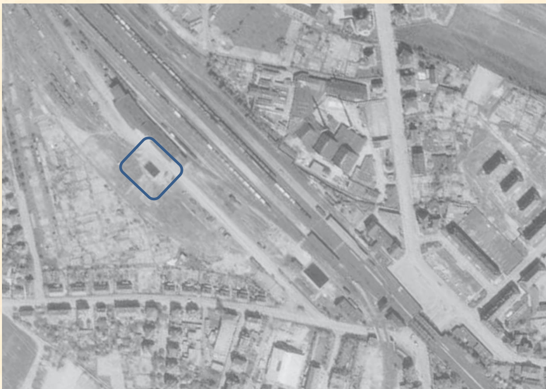
De ligging van de brandblusvijver op een luchtfoto uit 1945 (NARA, RG-373)
