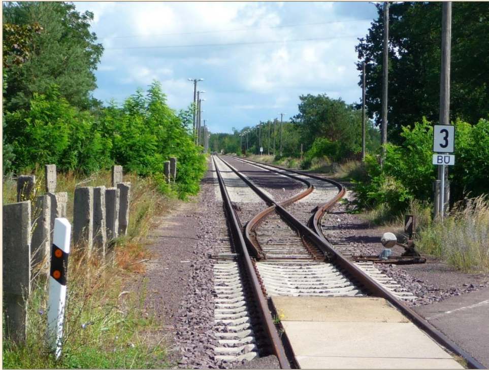
Het emplacement van Altengrabow vanuit de richting Loburg in 2015 (foto E. van der Most)
