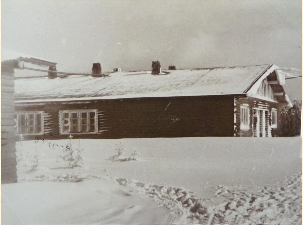
Barak op het terrein van Stegskopf (collectie Langhenkel).
