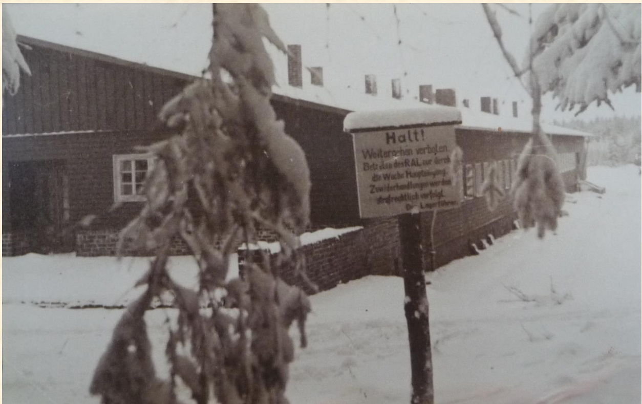
Barak op het terrein van Stegskopf (collectie Langhenkel).
