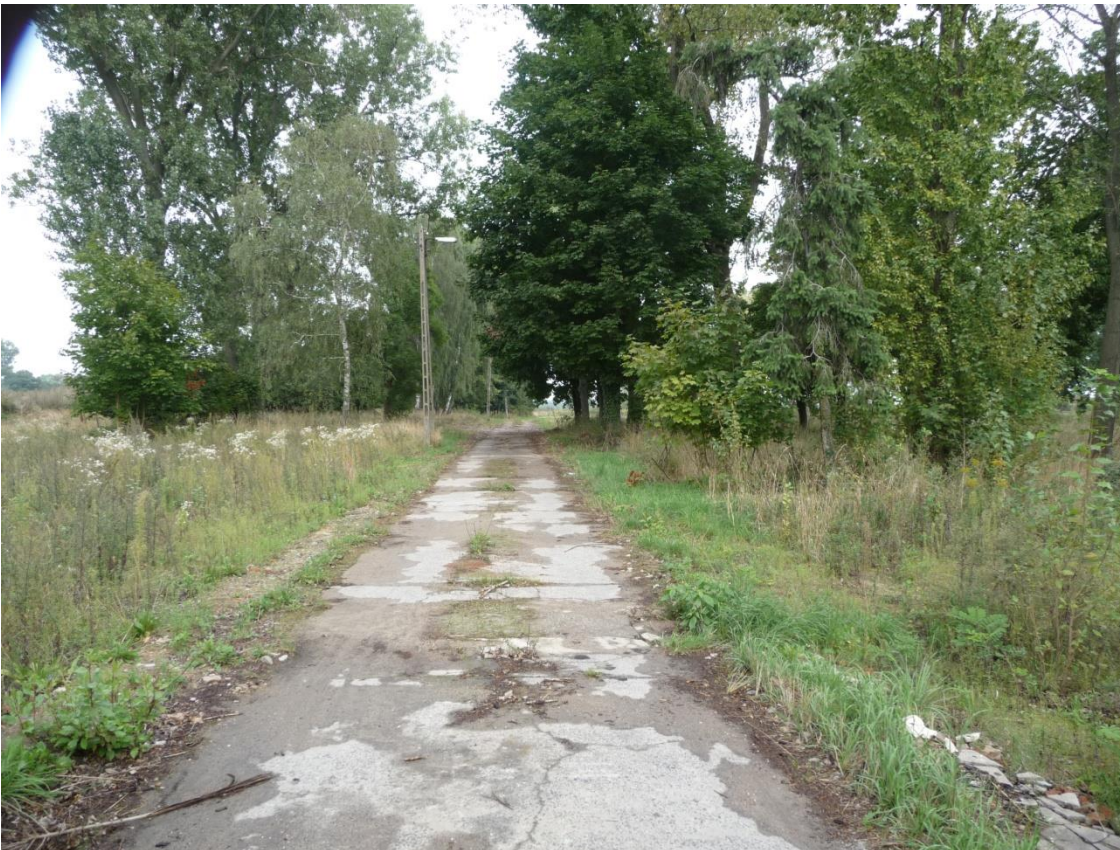
Betonpad op het terrein van het voormalige kamp, (foto auteur, augustus 2014).
