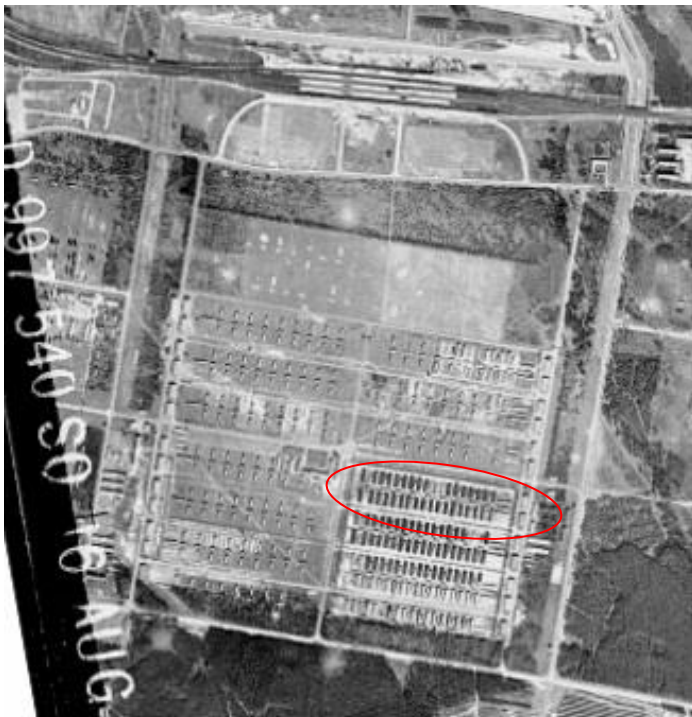
Luchtfoto van Oflag XIII B Langwasser met de Nederlandse barakken in de elips.
