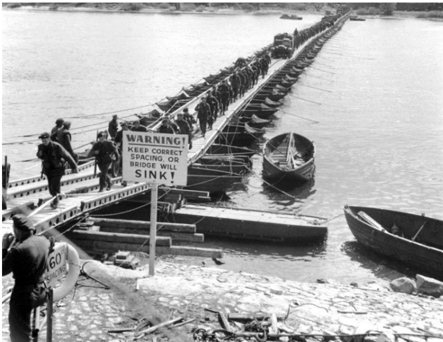
De pontonbrug over de Elbe bij Lauenburg
