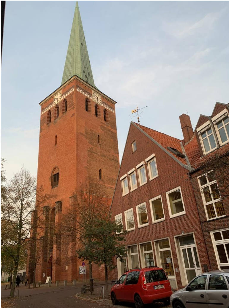
Duidelijk zichtbare herstellingen aan de St Marien Kirche van Uelzen (foto E. van der Most 2019)
