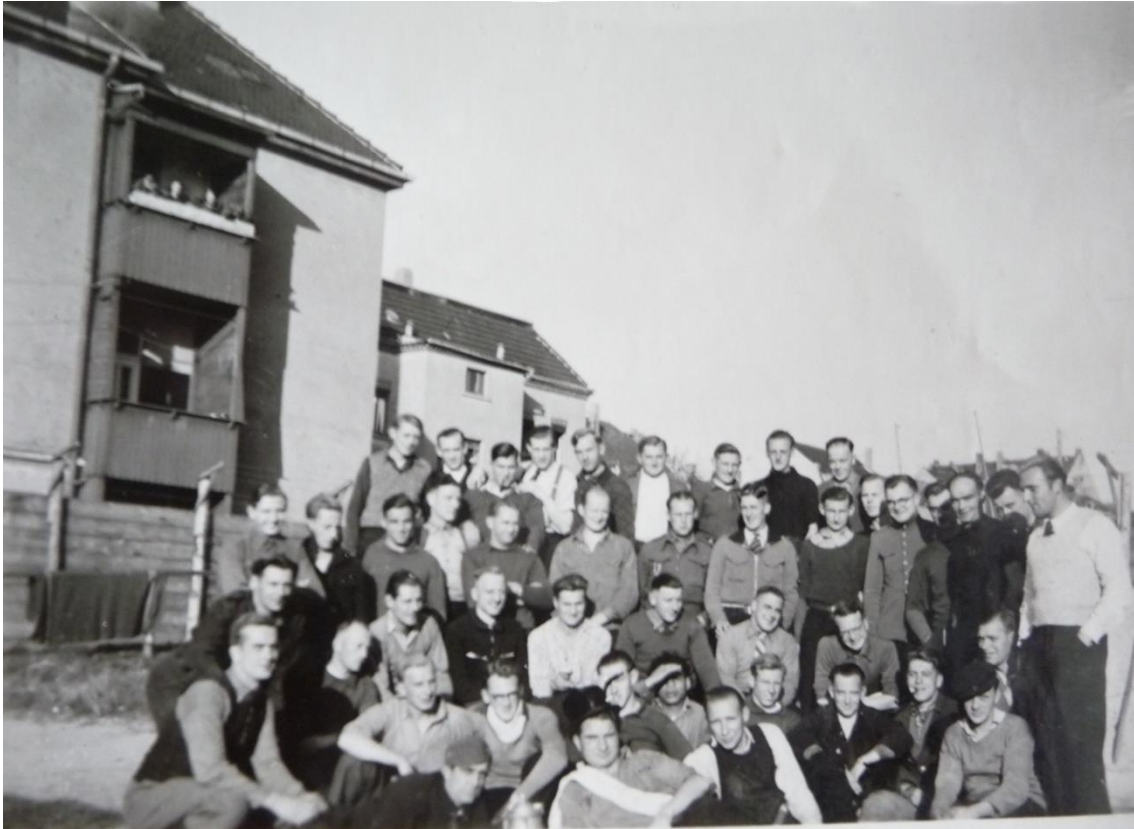
Zicht in noordoostelijke richting met links de achtergevel van een woonblok aan de oostkant van de Luckaerstrasse, midden de achtergevel van het woonblok aan de Kötzschauerstrasse te Leipzig, (collectie H. Tjepkema).
