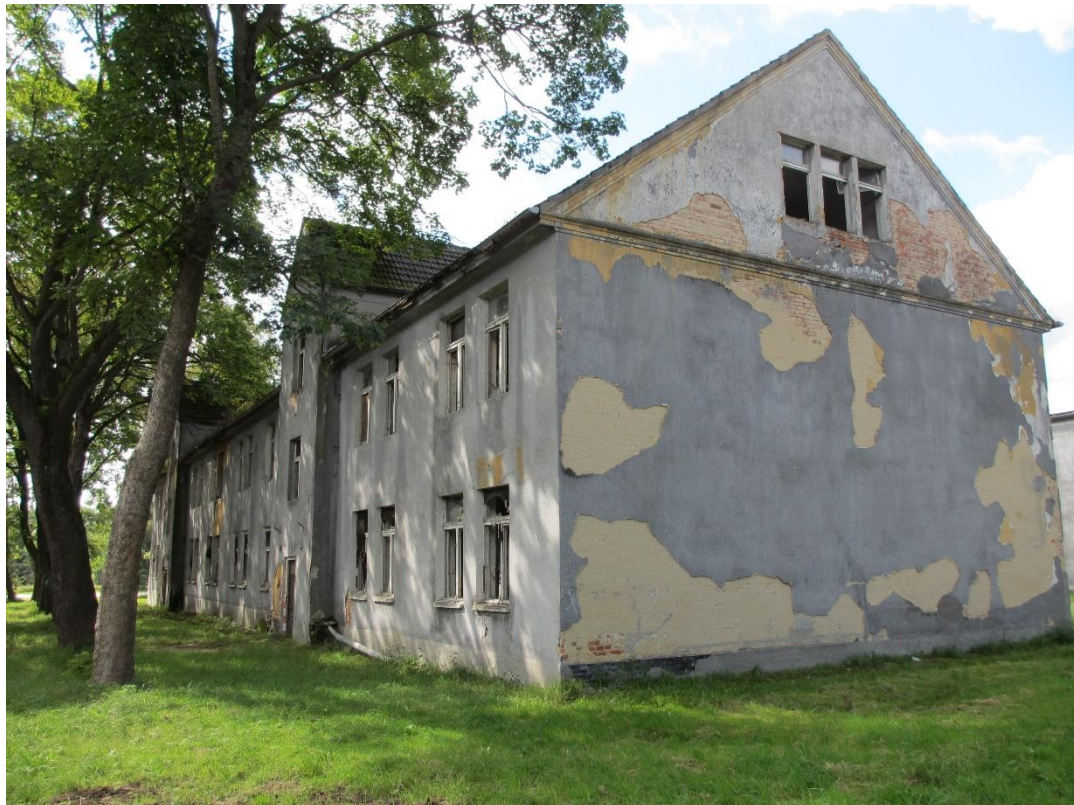
Gebouw ("Hochbau") van de studenten in 2015 (foto collectie Johan van Hoppe)
