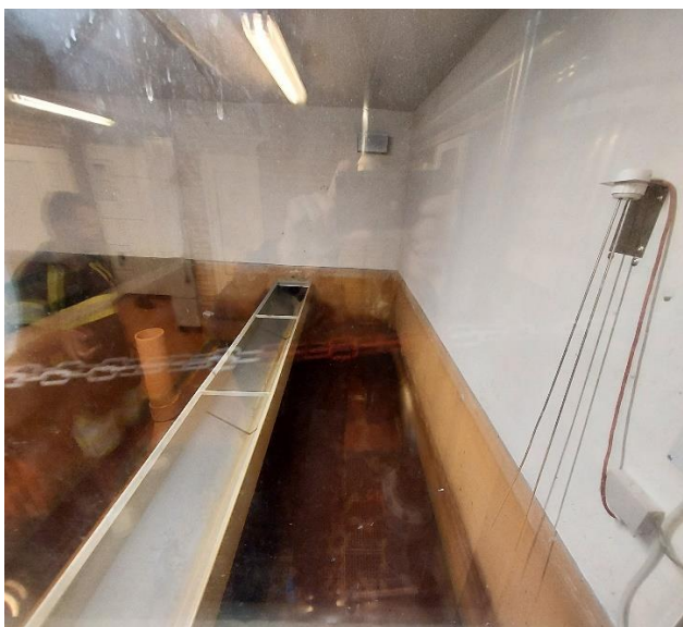
Foto 12 Åben sandfilter, ingen tegn på algebelægning på væggene. Rummet er under tryk og overtryk ledes ud af ventilation.
