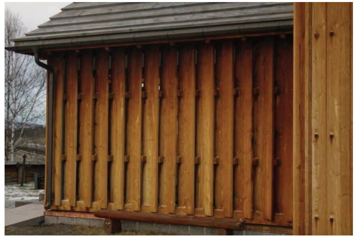
Skråstilt stående panel gir spesielle lyseffekter inne i kirka; lys slipper inn på dagtid, slipper ut når det er mørkt
