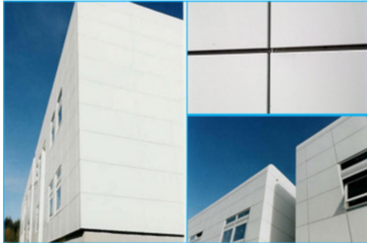
백색 태양광 패널 실제 시공예시 (출처: Solaxess사 홈페이지)
