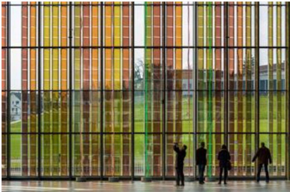
반투광 태양광 패널 시공사례 (출처: https://www.detail.de/ )
