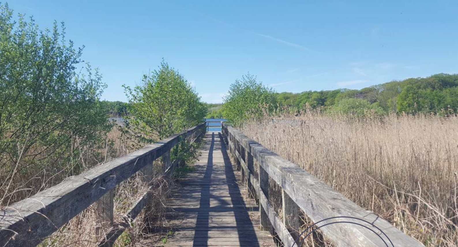
DEN EKSISTERENDE BRO VED CAMPINGPLADSEN
