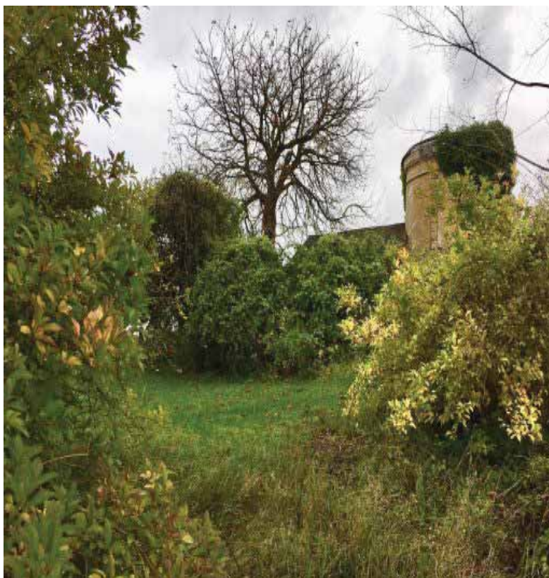
Lokalplanområdet set mod syd. Det gamle Vandtårn ses.
