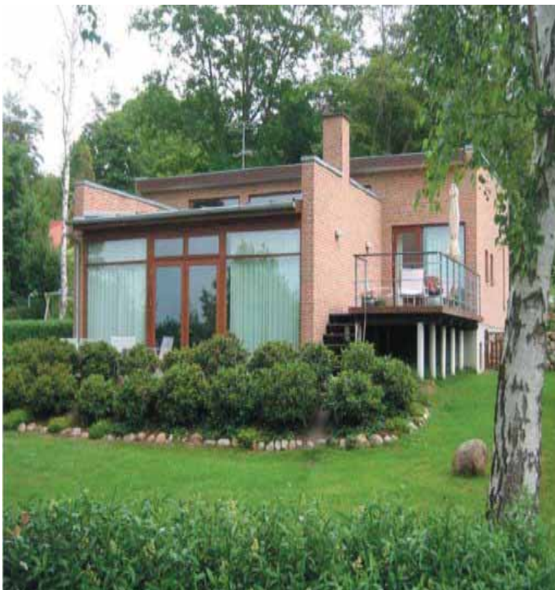
Endnu et eksempel på byggeri med forskudte etager, der arkitektonisk udnytter naturligt terræn.
