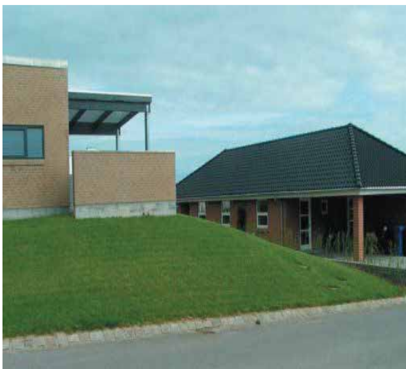
Eksempel på terrænregulering udført tæt på skel, hvilket kan være til gene for naboen.
