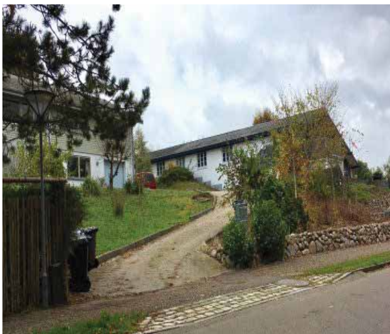
Nuværende vejadgang til matr. nr. 15hp. Denne vej skal udvides og udægges til privat fællesvej
